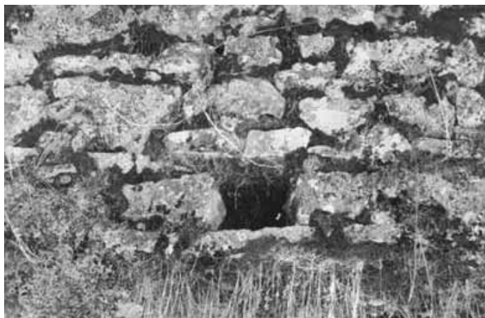
Εικόνα 5: Άποψη πολεμίστρας από το εσωτερικό του λιθόκτιστου μανδρότοιχου, που βρίσκεται στη νότια πλευρά.
